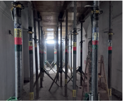
Während der Stabilisierungsarbeiten musste die Decke umfangreich gestützt werden.
