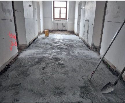
Eine Betonschicht, in der Eisengitter eingearbeitet wurden, stabilisiert die Gewölbedecken zwischen Gemeindeamt und Arztpraxis.
